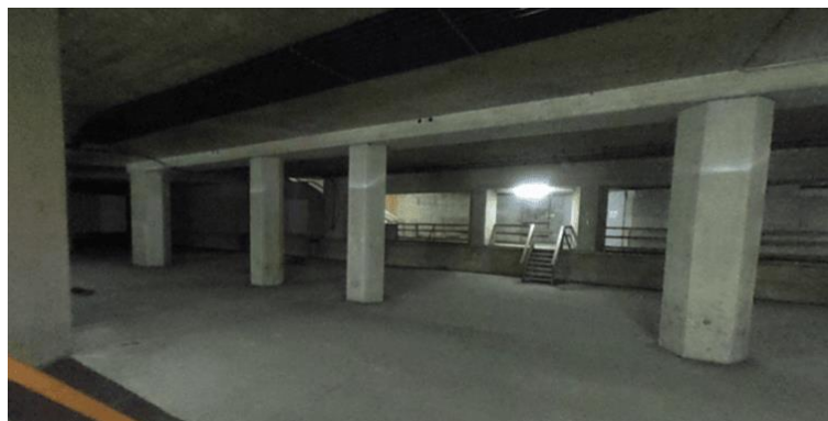
Abbildung 1. Rohbau der zweite Bahnsteigebene am Hauptbahnhof Hannover (Initiative Pro D-Tunnel e. V., 2019a)
